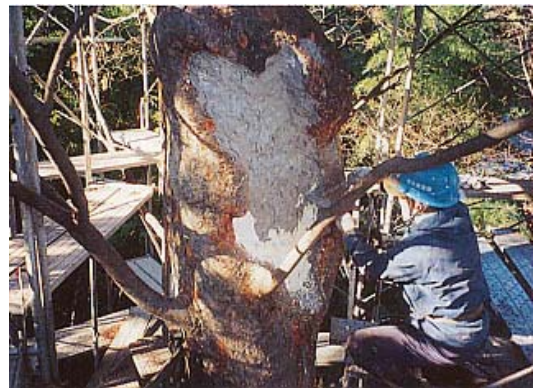
コーティング作業の様子
